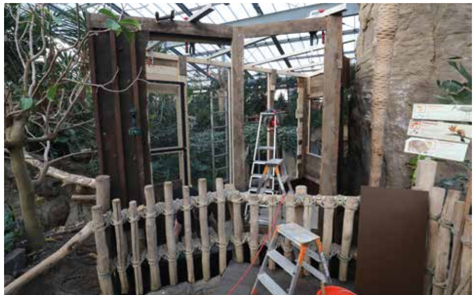
Abb. 24: Bau einer Anlage für Rotschulter-Rüsselhündchen im Hippodrom.
