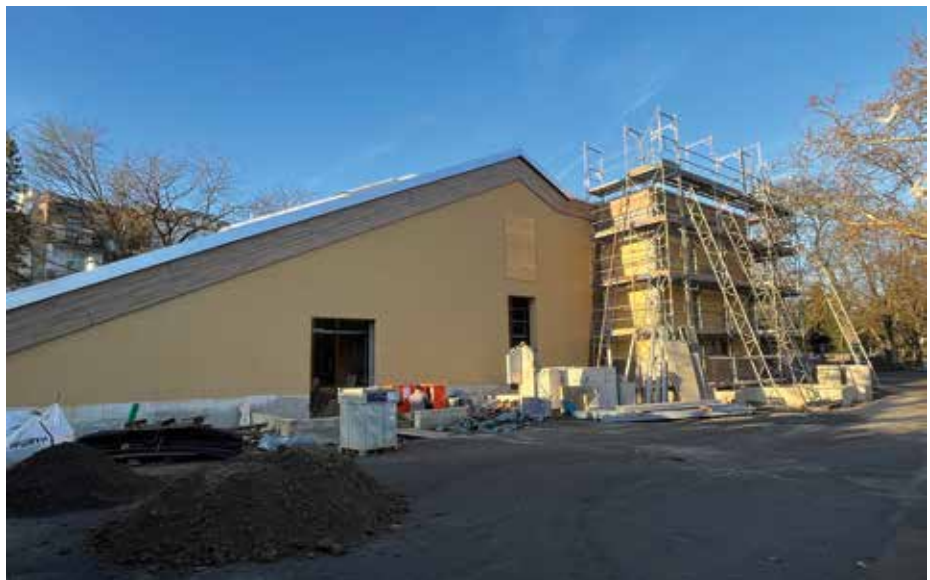
Abb. 86: Das im Bau befindliche Giraffenhaus. The giraffe house under construction.
