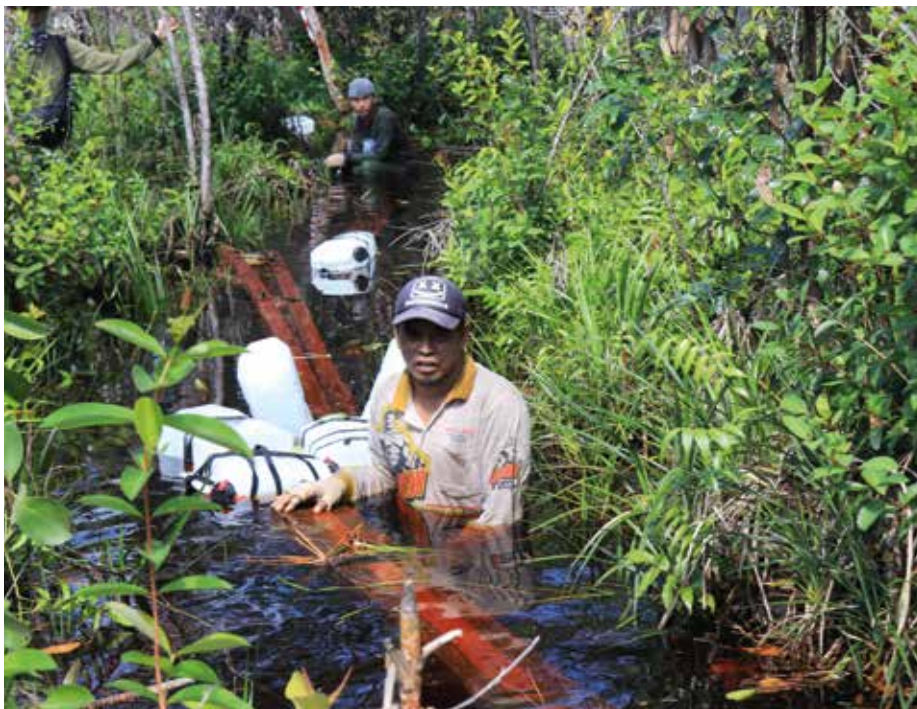
Abb. 52: Im feuchten Torfpfumpwald ist der Bau von Dämmen kein leichtes Unterfangen.
