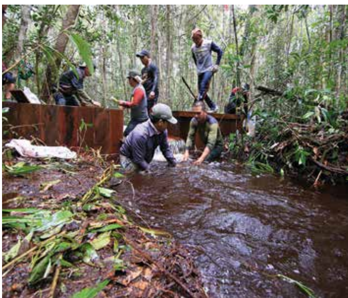
Abb. 62: Bau von Dämmen im Kanal „Bahkan“. Dams built on canal Bahkan.
