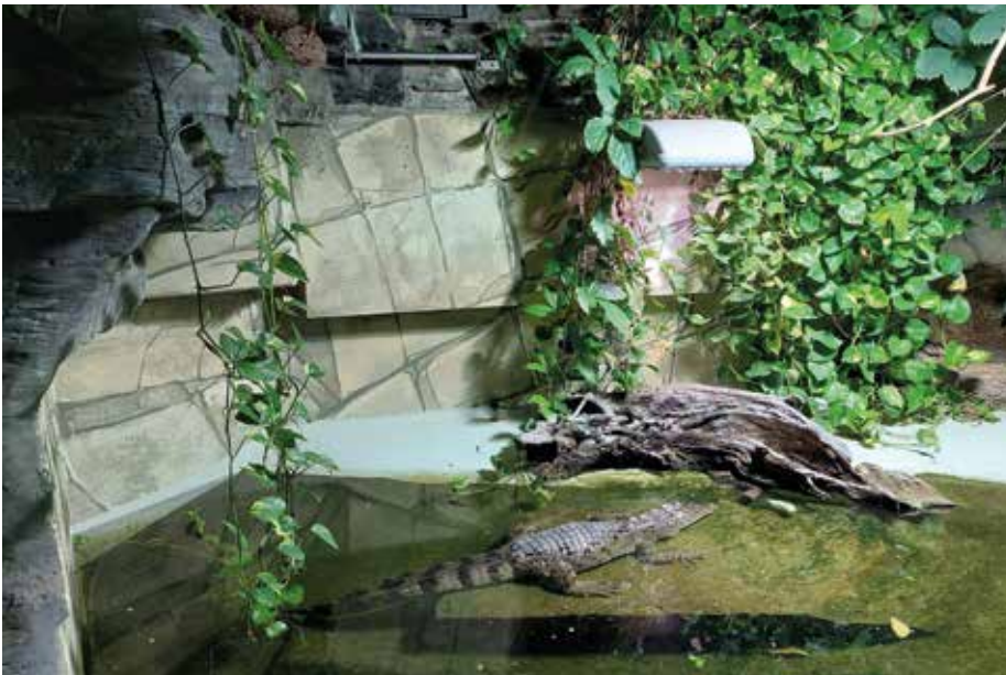
Abb. 99: Die Anlage der Philippinenkrokodile mit den sanierten Betonwänden. The Philippine crocodile enclosure with the renovated concrete walls. (Foto: M. Vreemann)
