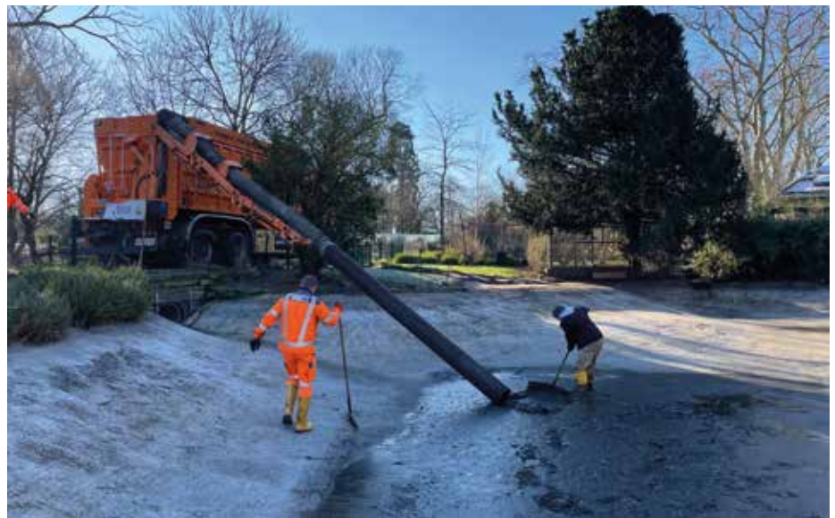
Abb. 91: Die Entschlammung ist wichtig für die Zoogewässer, um den Sauerstoffgehalt des Wassers zu erhalten. Sludge removal is important for the zoo ponds in order to maintain the oxygen content of the water.
